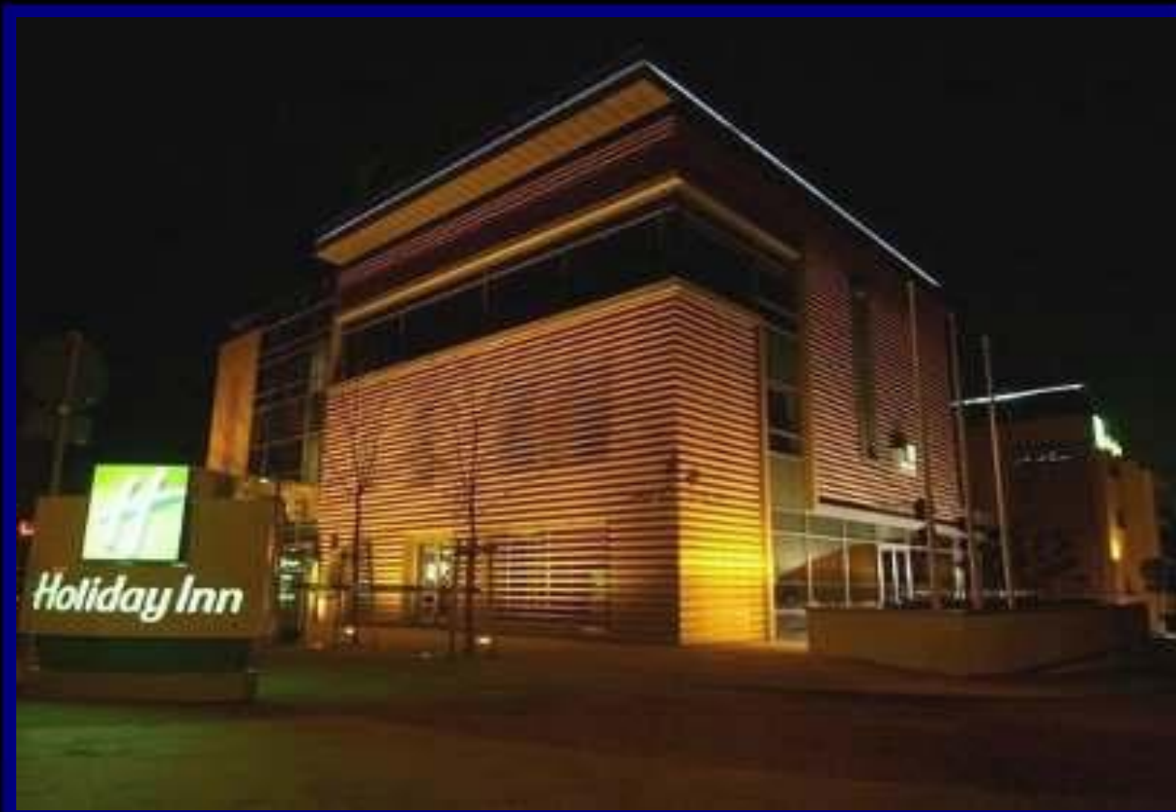
Nowoczesny budynek hotelu „Holiday Inn „ - przy ul. Bernardyńskiej
